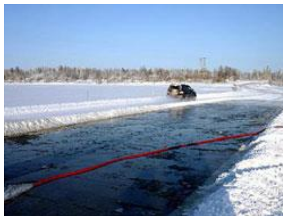
Рис. 4. Армирование ледяного покрова геосинтетическими материалами: а - укладка стеклосетки; б - заливка переправы водой
