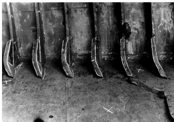
Рис. 1. Повреждения узлов кичных соединений
