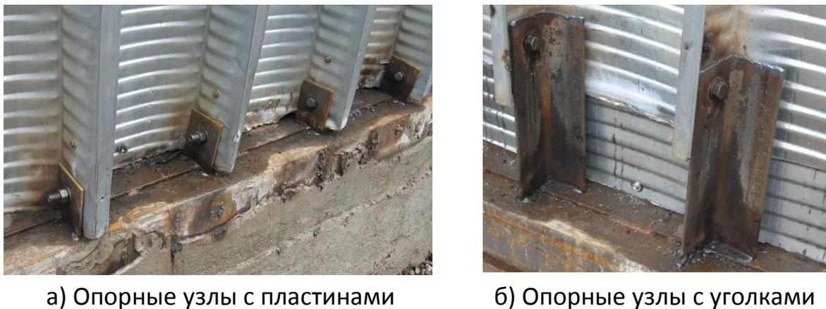
Рис. 4. Конструкции опирания бескаркасных покрытий
