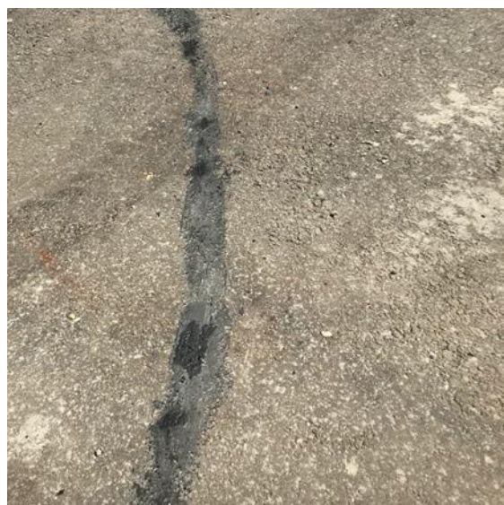
Рисунок 5. Подсыхание битумной суспензии на отдельных участках (составлено авторами)
