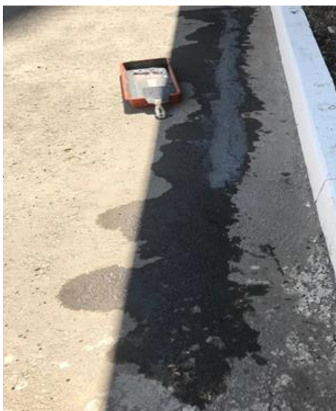
Рисунок 2. Смачивание трещины. Ремонт трещины битумной суспензией с помощью шпателя
