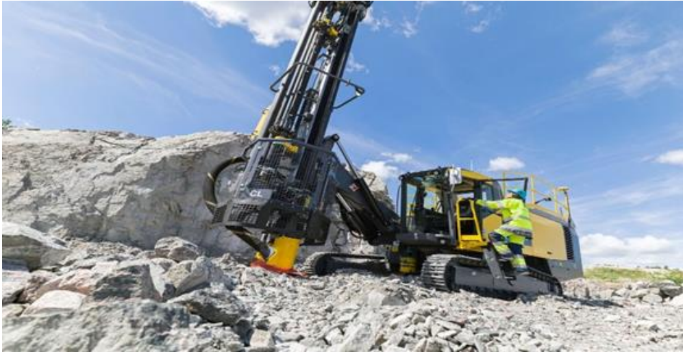
Рисунок 4. Буровая установка для взрывных скважин при рыхлении грунта
