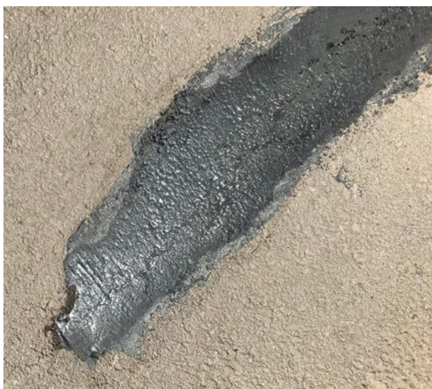
Рисунок 4. Превращение битумной суспензией в битумную пленку (мастичное состояние) в течение одного часа после начала работ
