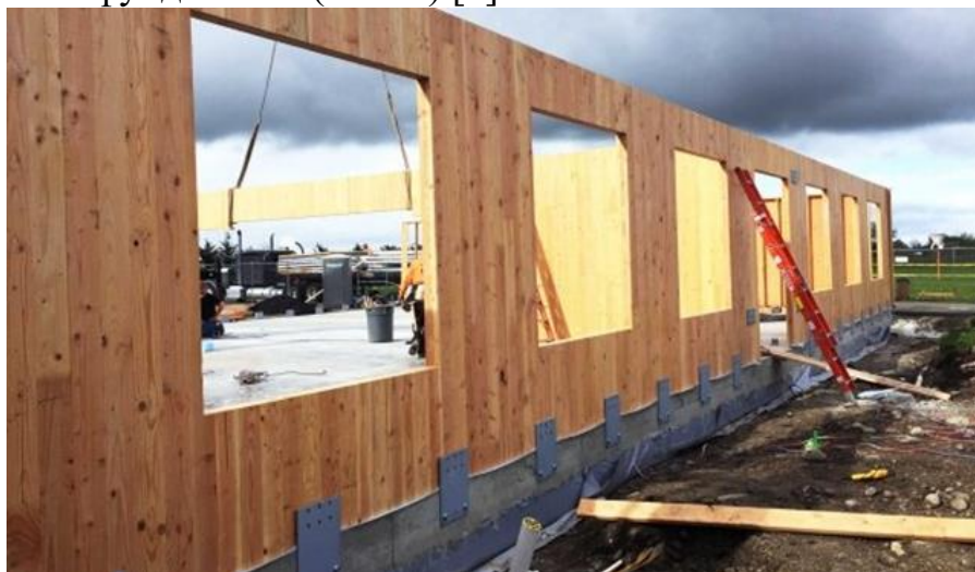
Рисунок 2. Здание из CLT панелей, на спец. фундаменте
