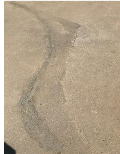
Рисунок 9 - Результат ремонта трещины битумной суспензией через месяц после производства работ (составлено авторами)
