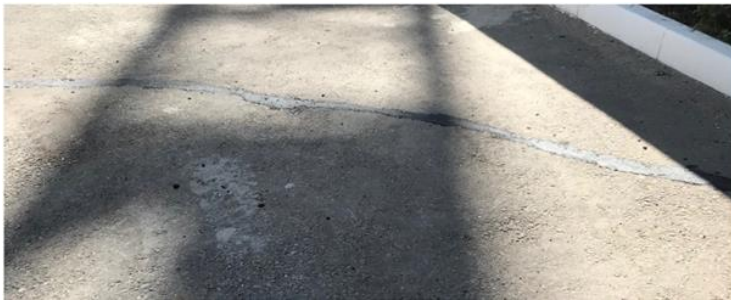
Рисунок 6. Превращение битумной суспензией в битумную пленку в течение одного часа после начала работ
