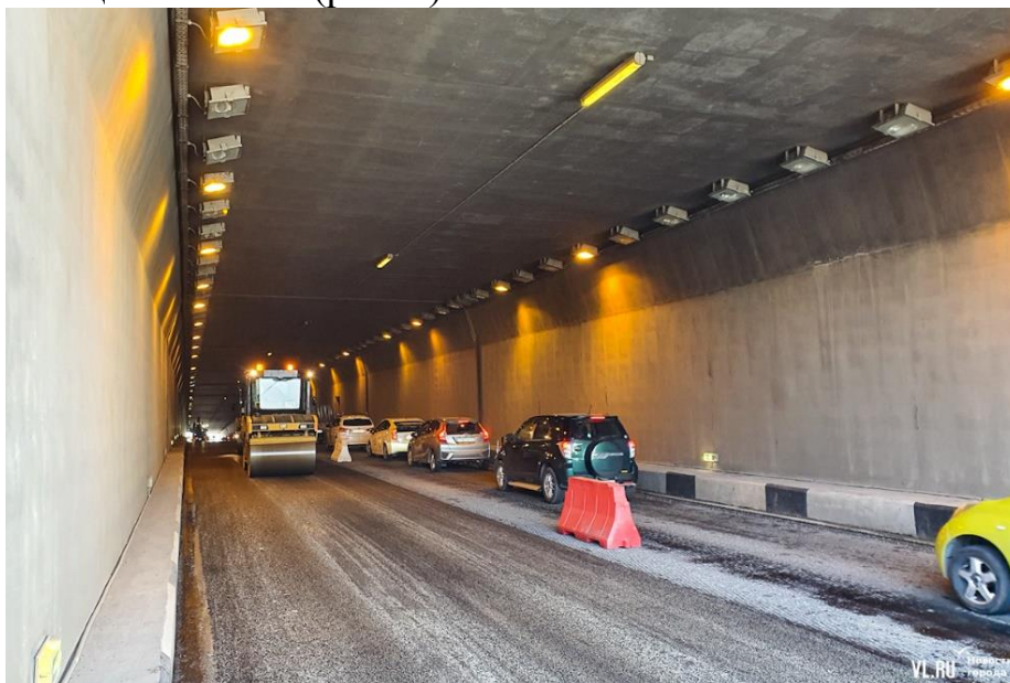
Рисунок 2. Ремонт дорожного полотна в тоннеле на выезде с Золотого моста. г. Владивосток
