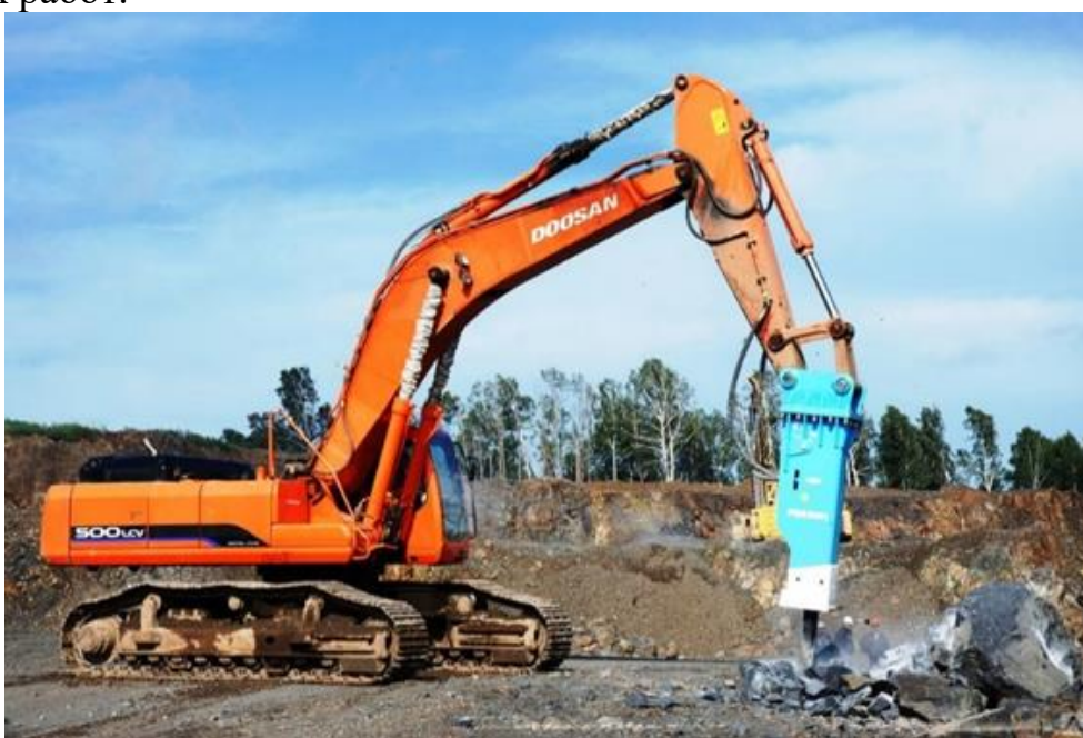
Рисунок 3. Применение гидромолота на экскаваторе
