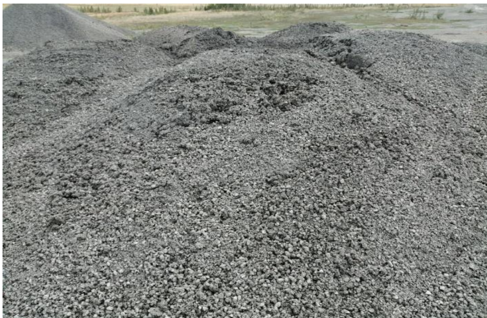
Рисунок 1 - Буртование битумной суспензии и холодной асфальтобетонной смеси с диспергированным битумом типа Б2
