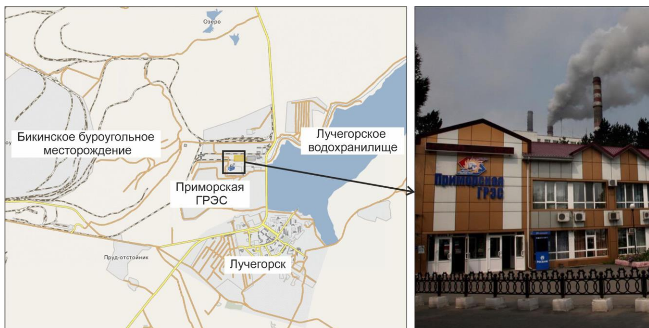
Рисунок 1 – Приморская ГРЭС, работающая на бикинском буром угле
