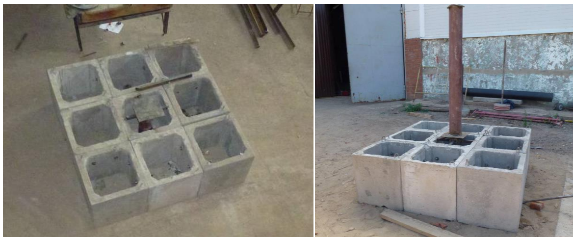
Рисунок 1. Конструкция сборно-разборного фундамента под опору
