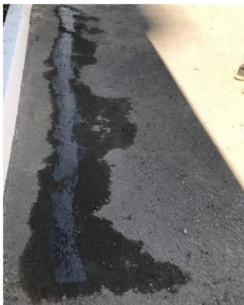
Рисунок 3. Сохранение влажного состояния битумной суспензии на теневой стороне (составлено авторами)
