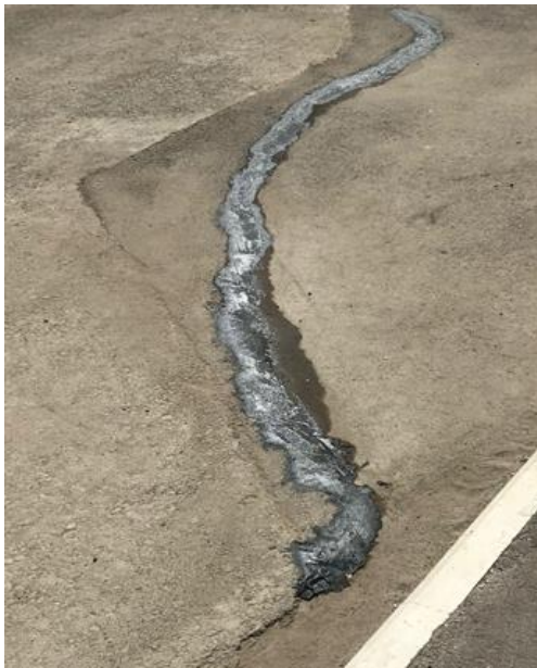
Рисунок 6. Превращение битумной суспензией в битумную пленку в течение одного часа после начала работ
