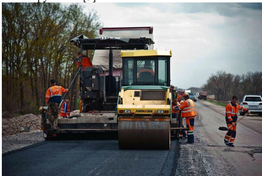
Рисунок 3. Частичное реконструирование автодороги
