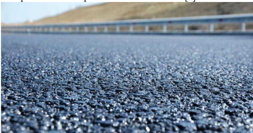
Рисунок 1. Использование гранитного наполнителя для строительства дорожных покрытий автомобильных дорог
