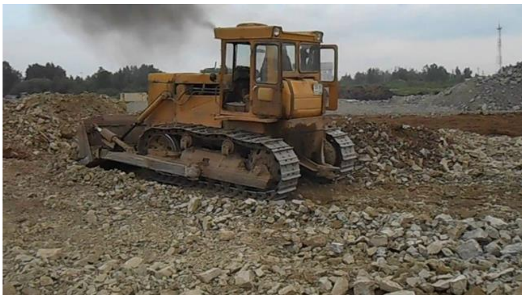
Рисунок 2. Буртование скального грунта бульдозером
